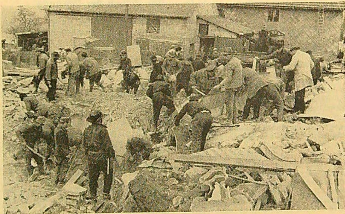
Die Explosionsstelle während der Bergungsarbeiten
