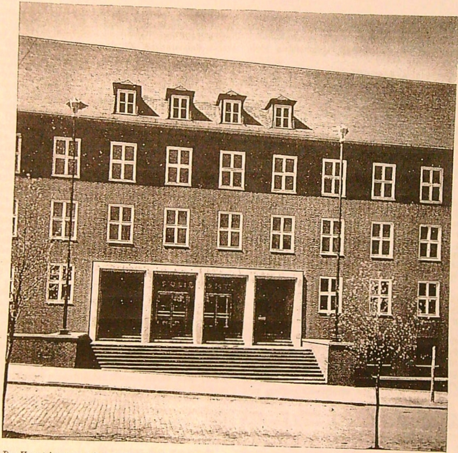
Der Haupteingang an der von Bockstraße mit den beiden Adlerrmasten von Professor Merten, Essen. Wand- und Pfeilerverkleidungen der Vorhalle in Muschelkalk (vgl. Einzelheit der Eingangstüren auf S. 893). Unten: Sockelgeschoß des Hauptgebäudes und zweites Obergeschoß des Wohnungs- und Gefängnisflügels. M. 1:700.
