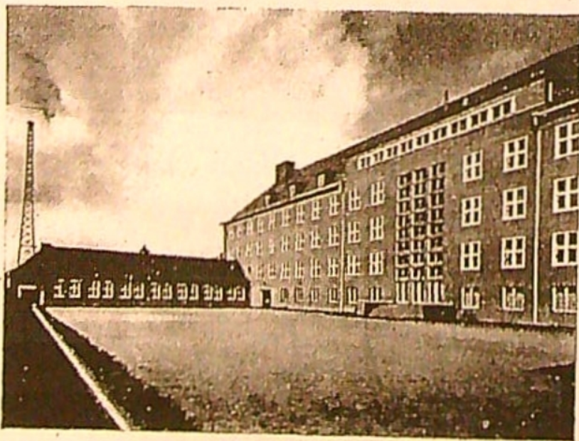
Der große Hof mit der Rückansicht des Hauptgebäudes.
